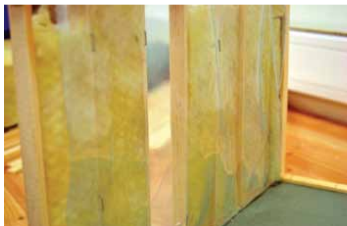
Fig 5B Langveggen har folie og isolasjon.
