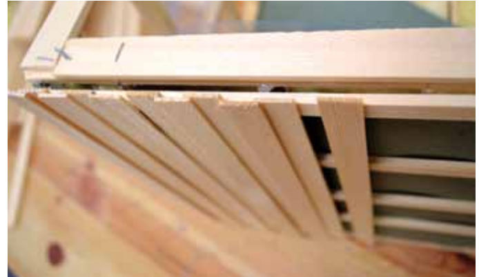
Fig 7 Her ser vi tydelig luftkanalen (liggende) mellom pappen og den stående bordkledningen sett ovenfra. Det er ramma til selve veggen vi ser øverst, langsgående.
