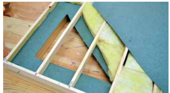
Fig 3 Grunnmur, papp, isolasjon, stendere og pappgulvet over.
