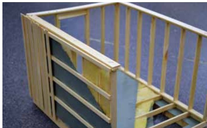
Fig 5A Bakveggen er på plass, den ene langveggen har fått isolasjon, vindpapp, spikerslag (som gir luftkanalene mellom vindpappen og kledningen) og stående bordkledning.
