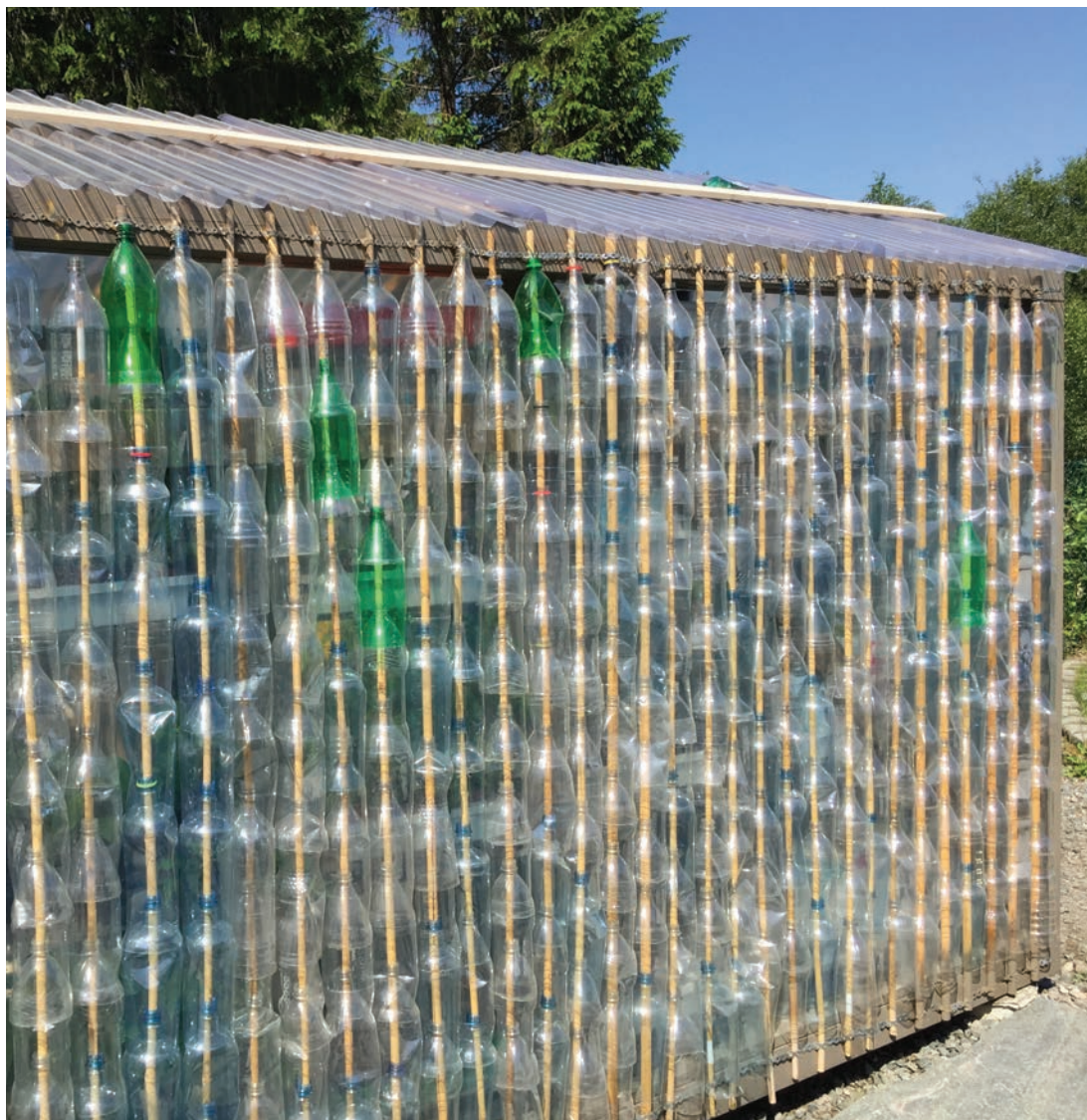
Elevene på sjuende trinn samlet plastflasker gjennom et skoleår, og fikk hjelp av vaktmester til å bygge et drivhus. Flaskene ble tredd på bambusstokker og festet til et rammeverk. Foto: Søråshøgda skole
